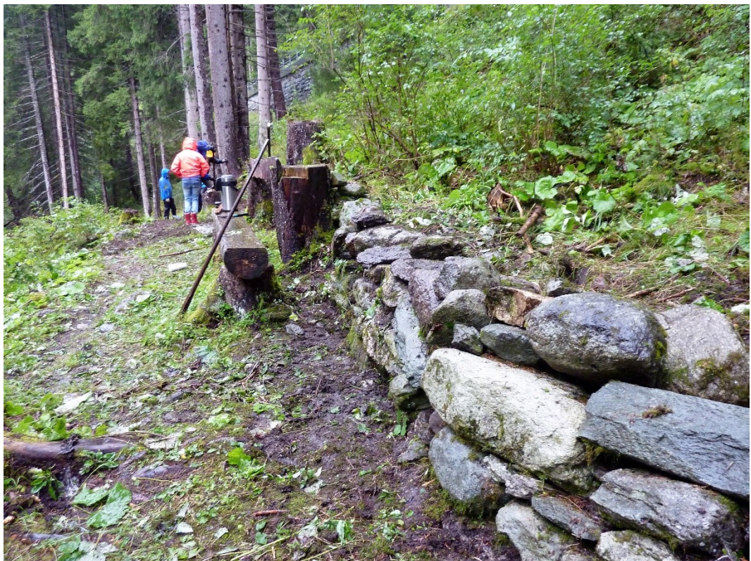
Freigelegte und erneuerte Trockenmauern
